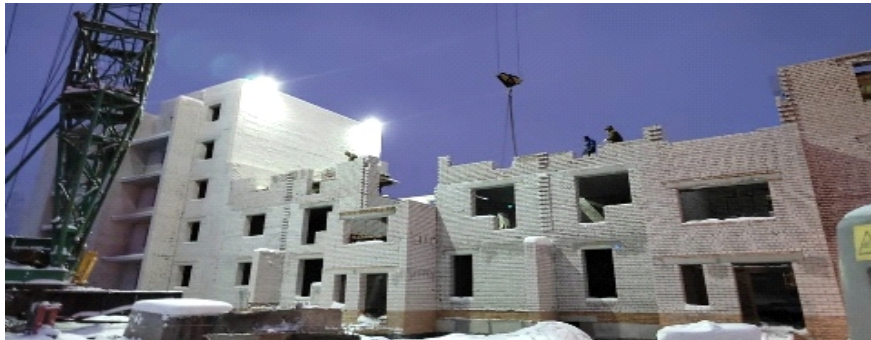
Г. НОВОДВИНСК, УЛ. ДОБРОВОЛЬСКОГО
