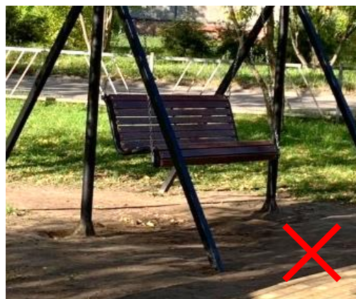
Высокий уровень подвеса качели, отсутствие подстилающего покрытия
